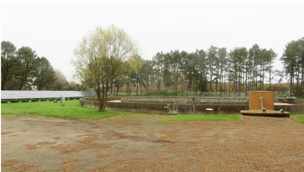
Figur 6 - Eksisterende kombitank bestående yderst af procestanken og inderst af efterklaringstanken samt solcelleanlæg indenfor lokalplanområdet.
