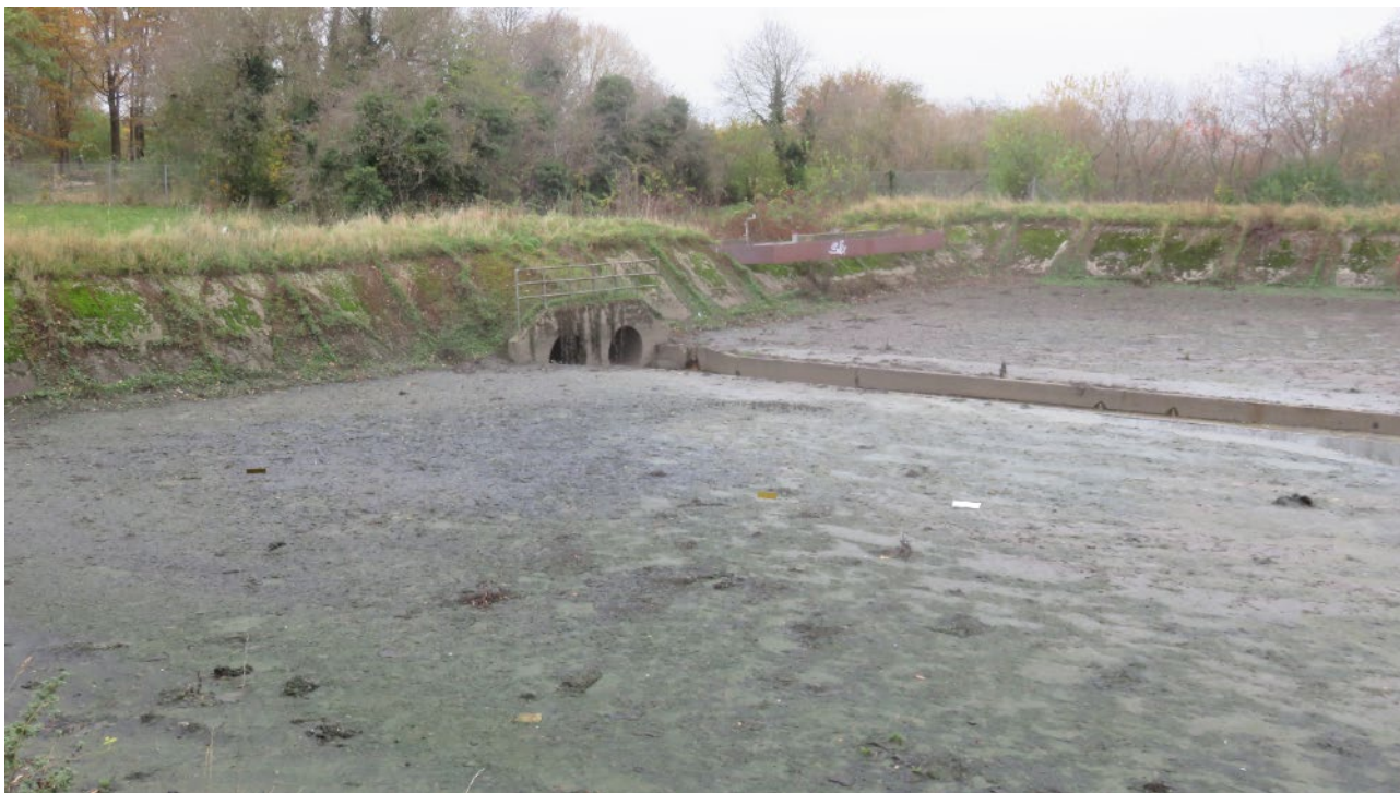
Figur 10 - Billedet viser det eksisterende sparebassin ved Kallerup renseanlæg
